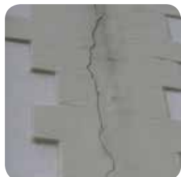
Bouwdynamische scheur
